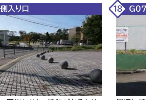
凹凸の大きい石畳と共に、傾斜があるため、車椅子の操作が難しいです。
