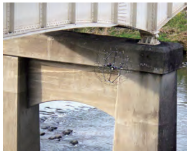
実橋梁での点検試行
