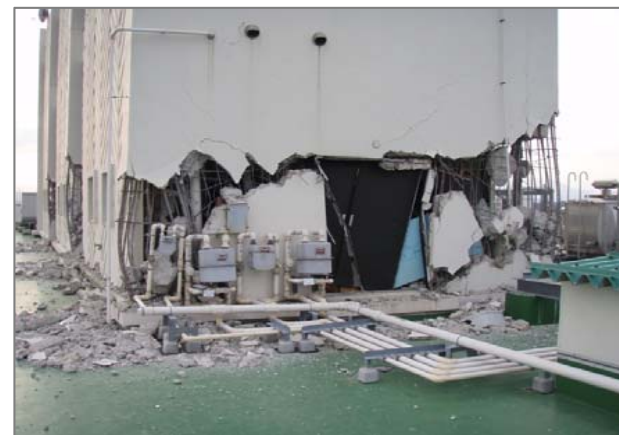
工学研究科電子・応用実験棟 塔屋の崩壊
