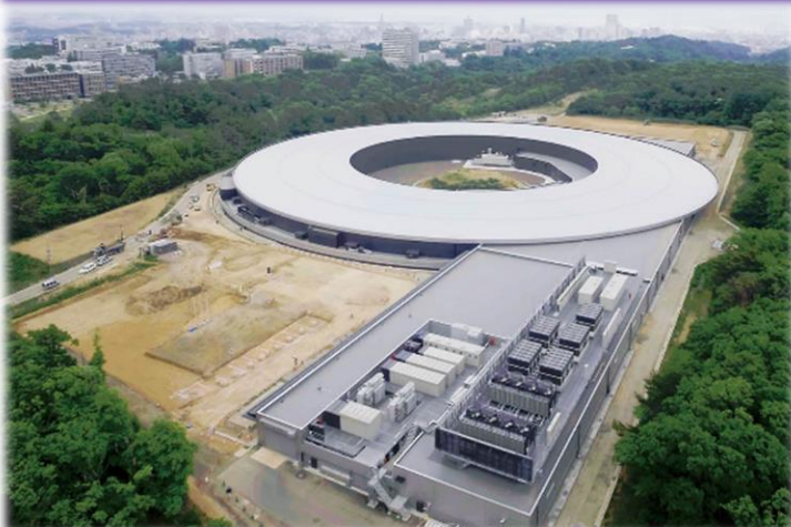
整備が進む次世代放射光施設 NanoTerasu（2022年5月現在）
