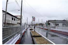
大熊町 避難指示解除区域(道路)
