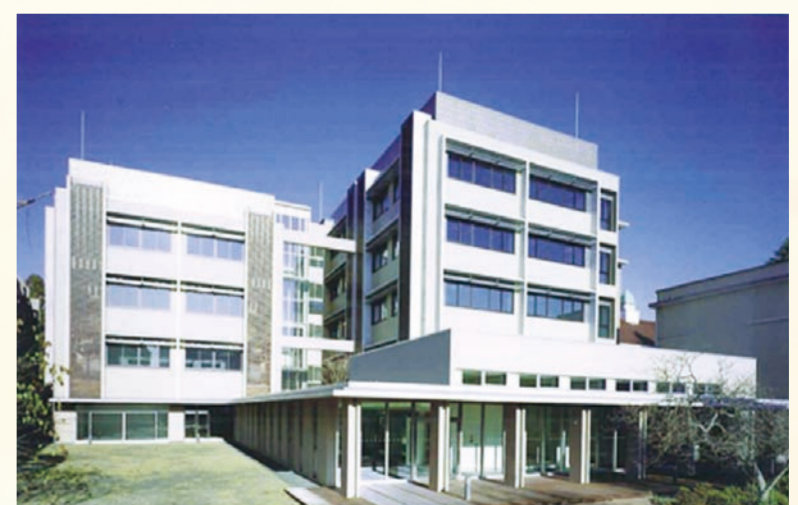
生命科学プロジェクト総合研究棟
