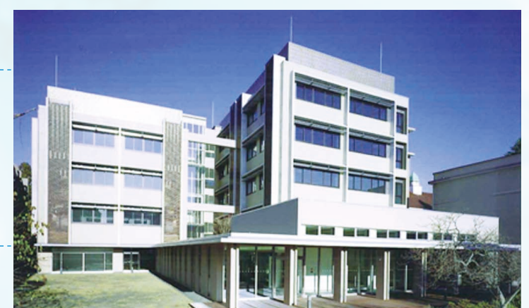
生命科学プロジェクト総合研究棟
