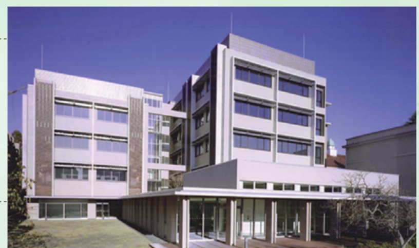
生命科学プロジェクト総合研究棟
