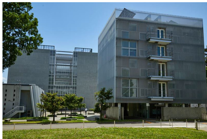
東北大学大学院工学研究科 マテリアル・開発系 共同研究棟（写真右）
