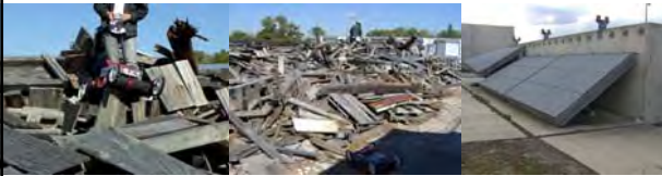
木材瓦礫を踏破(約10m) (2008.11.18-20) 斜面の横断
