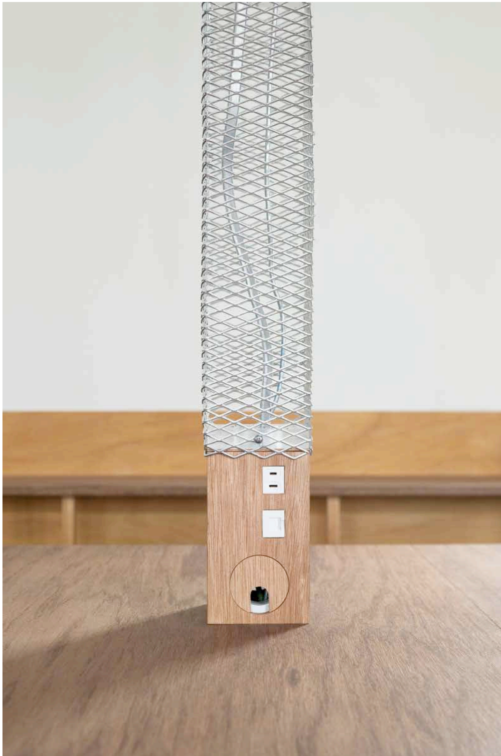
図2 磯部縮退 \pi 集積プロジェクト居室 デスク上情報コンセント部詳細. 天井からの配線がエキスパンドメタル内に格納されている.
