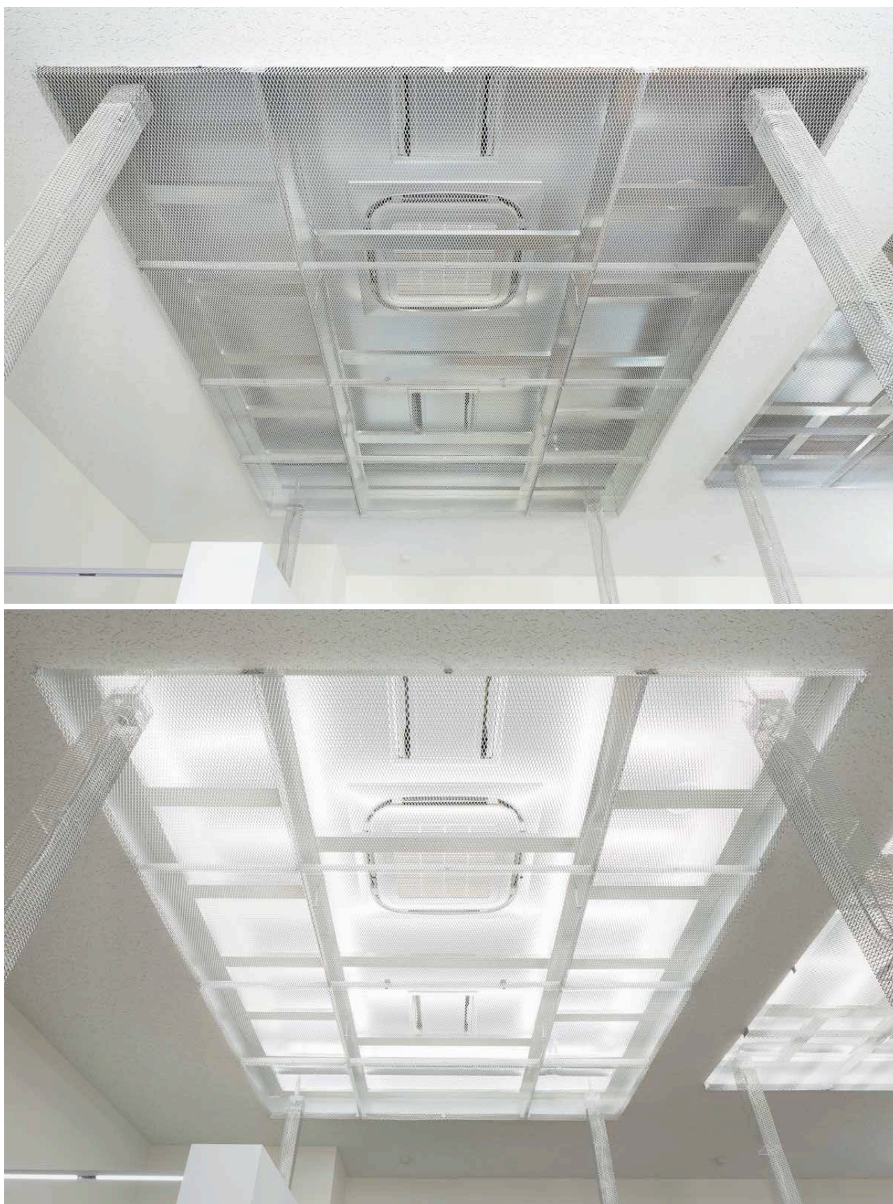
図3 磯部縮退 \pi 集積プロジェクト居室 天井詳細. 配線と間接照明に配慮がなされている. エキスパン ドメタル上部の天井部分は銀色塗装され, 反射光によるおだやかな作業環境をつくりだす.
